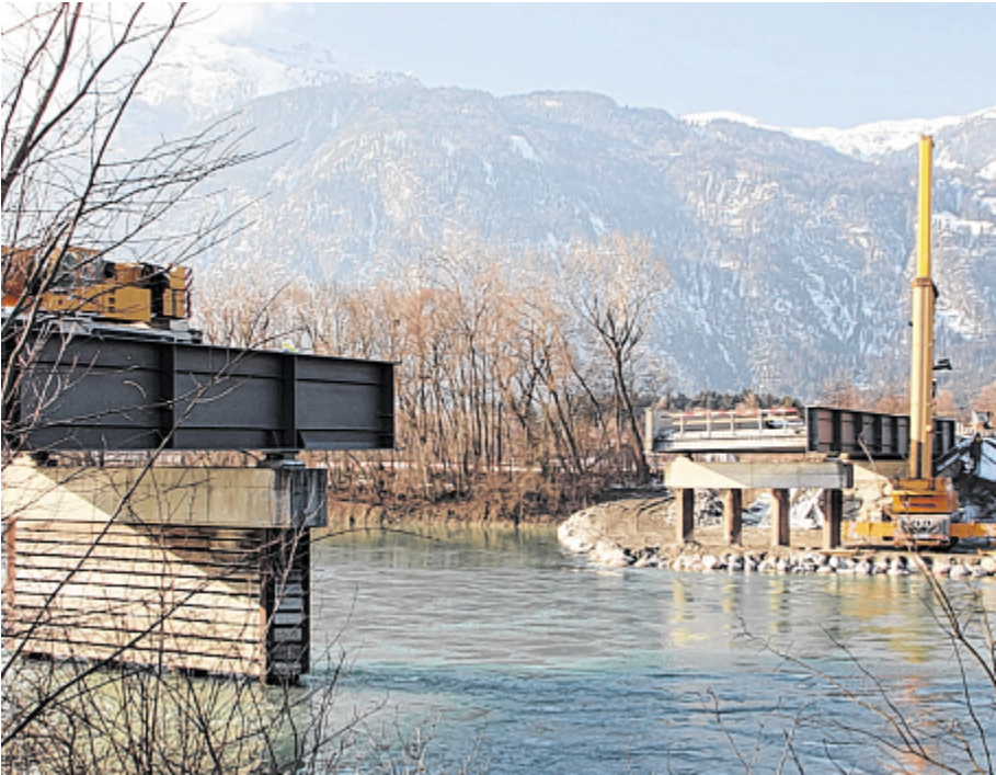
Die Brücke in Brixlegg wird mit Hilfe von Kränen abgebaut. Geschäftsmann Nicu Gabureanu will die Brücke in Rumänien wieder aufbauen. Fotos: Zoom-Tirol
